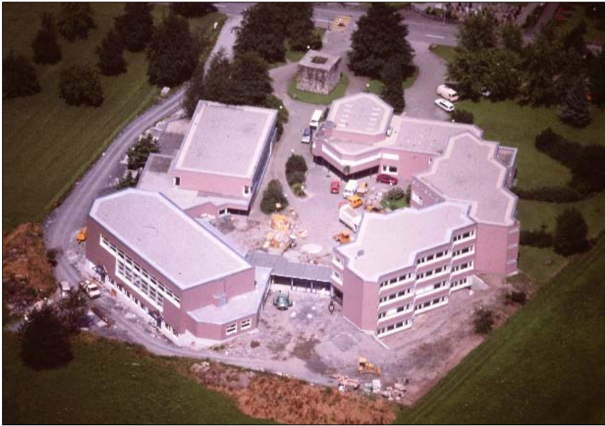
Abbildung | Erweiterung kurz vor Fertigstellung
