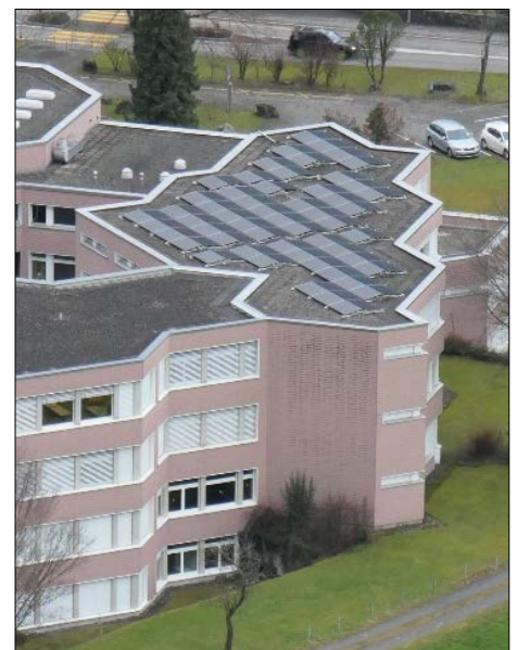
Abbildung | Fertiggestellte Photovoltaikanlage
