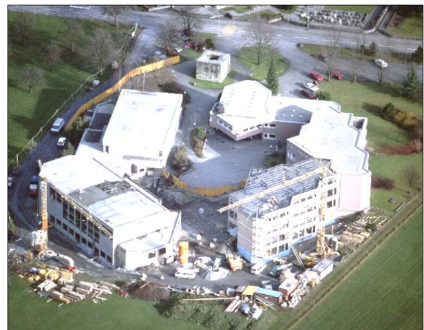
Abbildung | Baufortschritt am 10. Januar 1994
