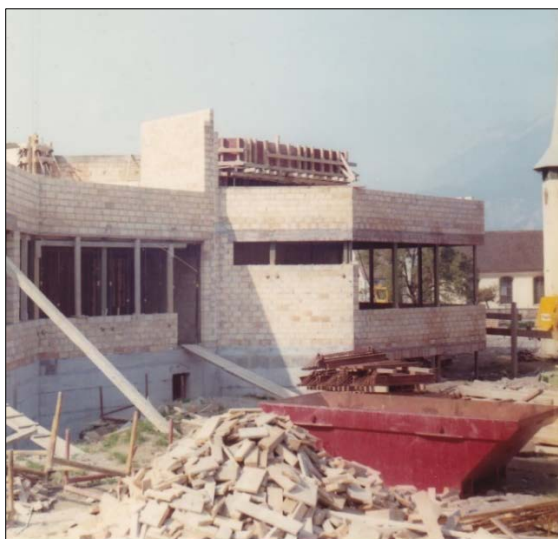
Abbildung | Baustelle am 4. September 1972
